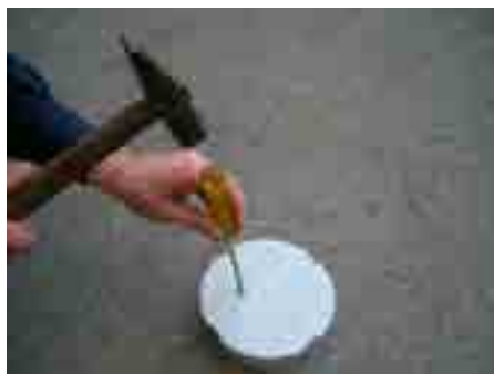
2. В монтажном элементе подготовить отверстия нужного диаметра
